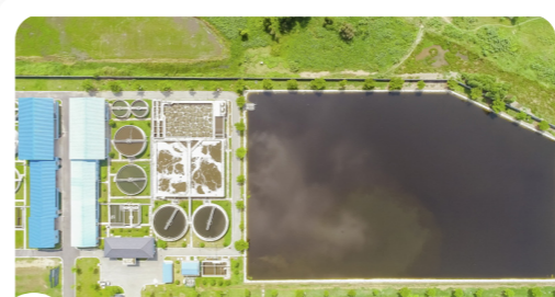
23 Hệ thống xử lý nước thải – Mộc Bài, Tây Ninh
