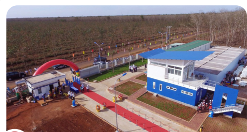
22 Nhà Máy Nước Chư Sê – Gia Lai
